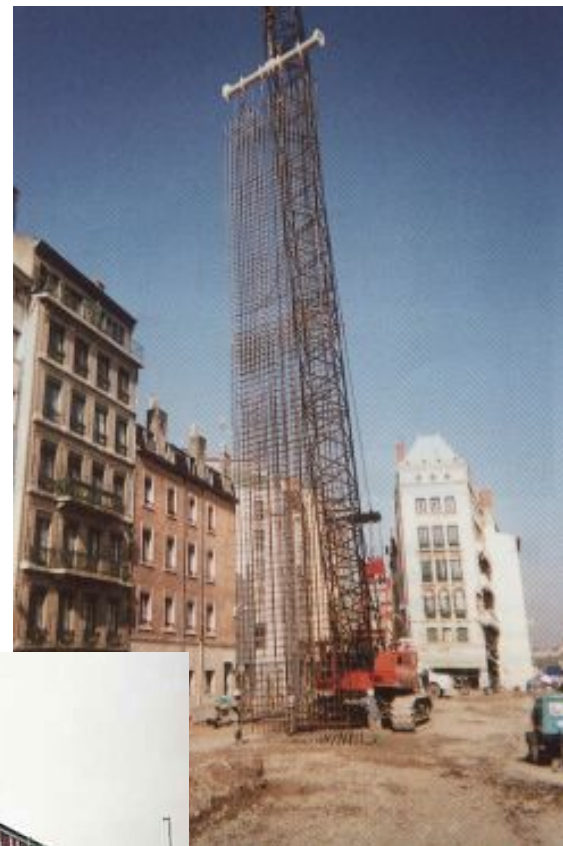
Mise en place de la cage d'armature
