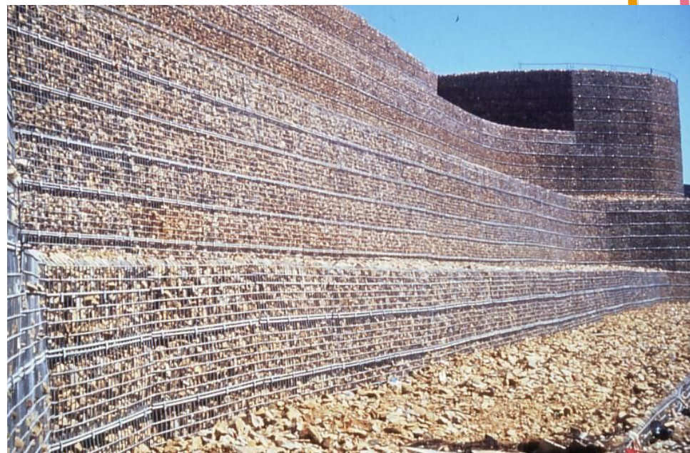
Exemple 3 : mur en gabions (plus souple)
