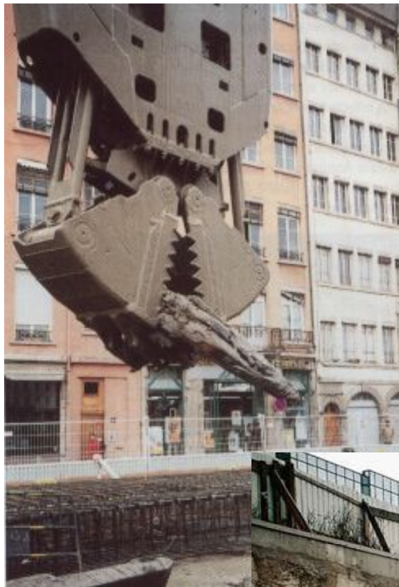
Excavation avec une benne preneuse
