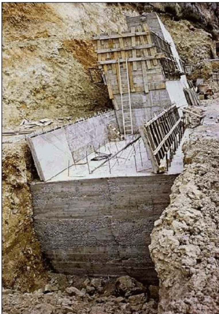
Exemple 2 : mur en béton
